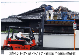
荷台上を見ながら慎重に運転操作
