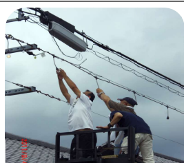
フォークリフトで提灯の配線作業
